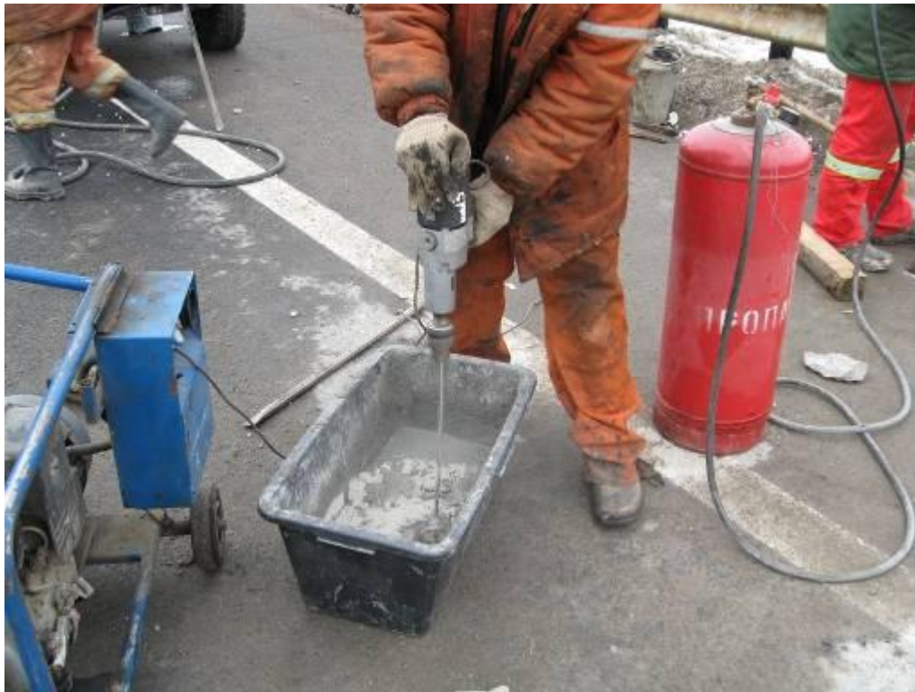
Рис.8. Подготовка быстротвердеющей смеси «EMACO» T545
