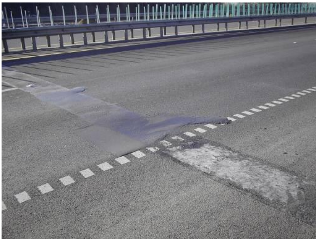
Рис.24. Выдавливание щебеночно-мастичного заполнения из полости шва
