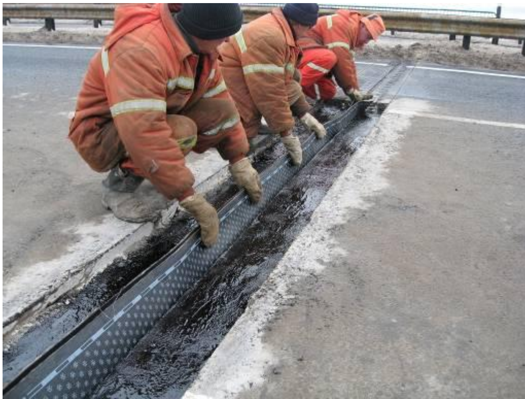
Рис.12. Установка компенсатора
