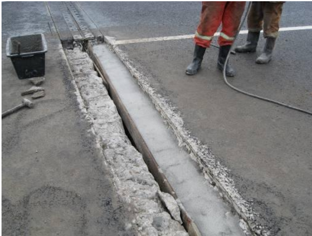
Рис.9. Устранение дефектов защитного слоя.
