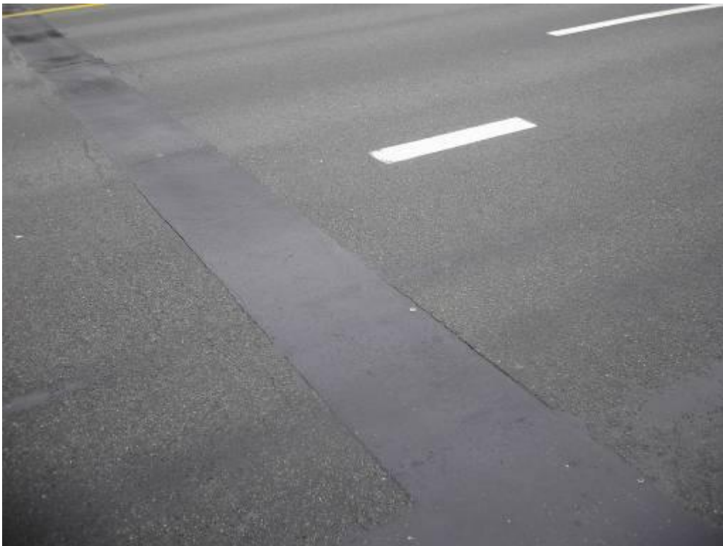
Рис.23. Локальные отрывы щебеночно-мастичного заполнения от стенок шва.
