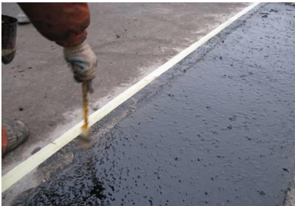
Рис.19. Огрунтовка кромок шва.
