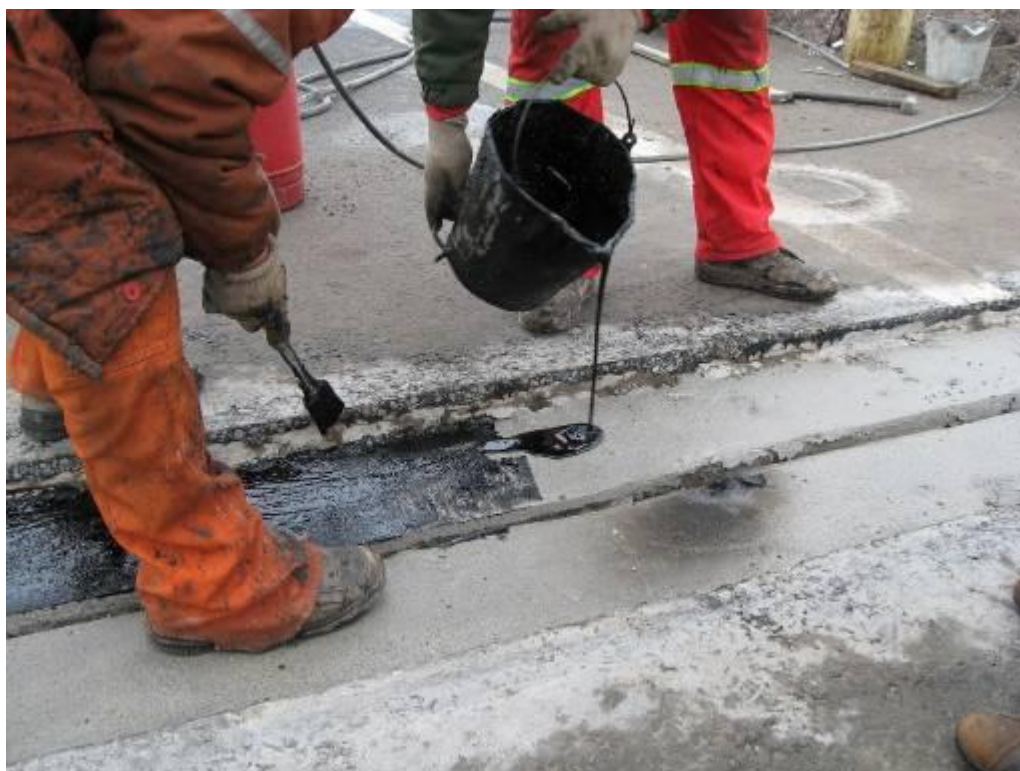
Рис.11. Грунтование дна шва
