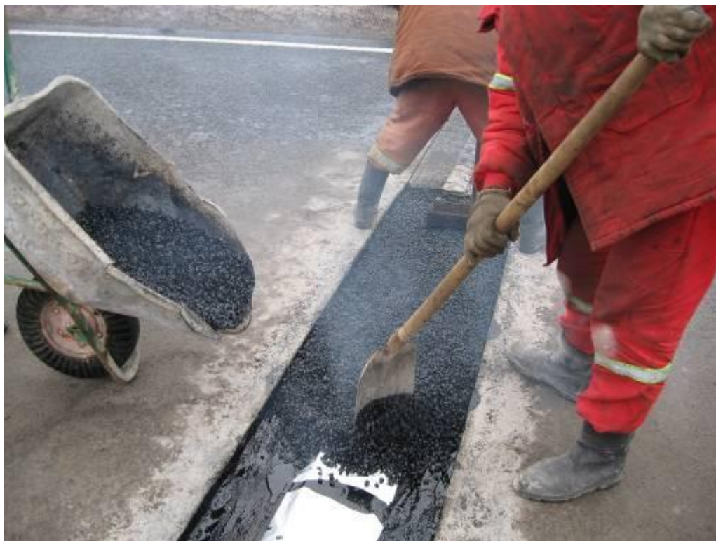
Рис.16. Заполнение полости шва разогретым и обработанным щебнем.
