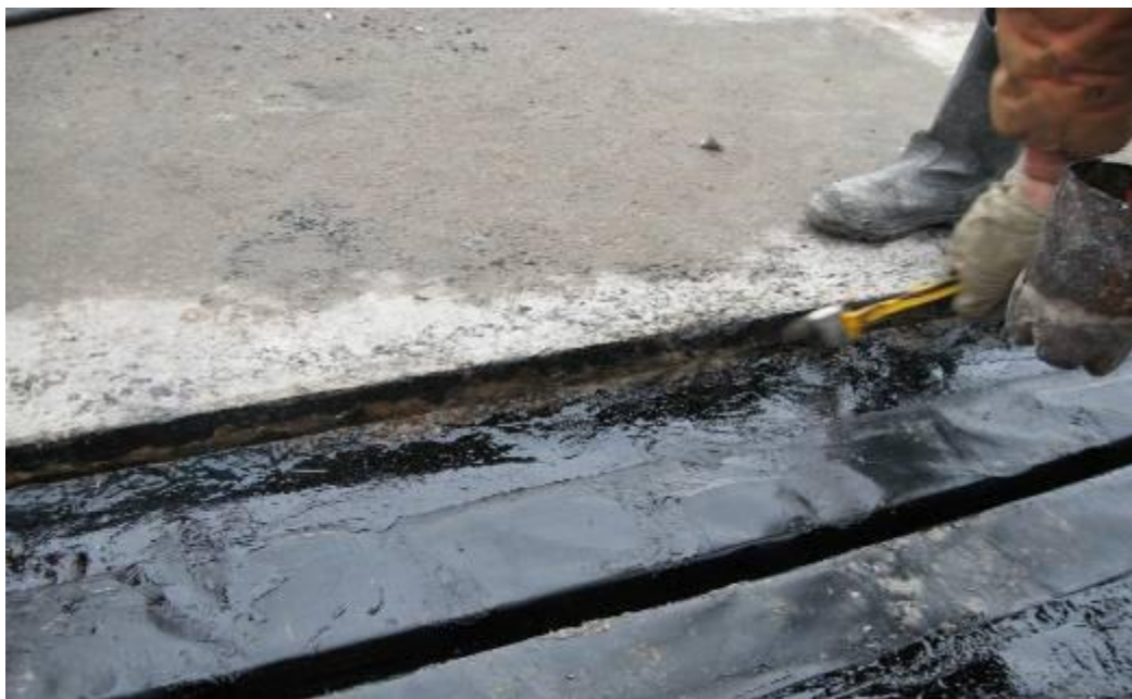
Рис.13. Грунтование стенок шва
