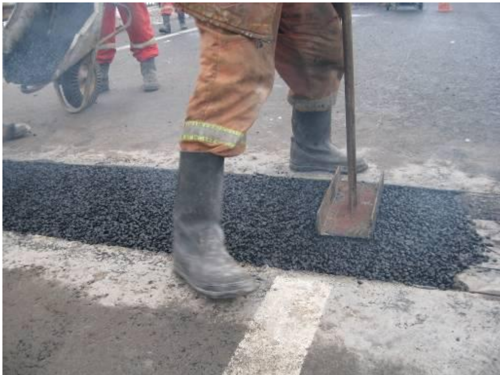
Рис.18. Уплотнение слоя щебня фр.5-10мм ручной трамбовкой.
