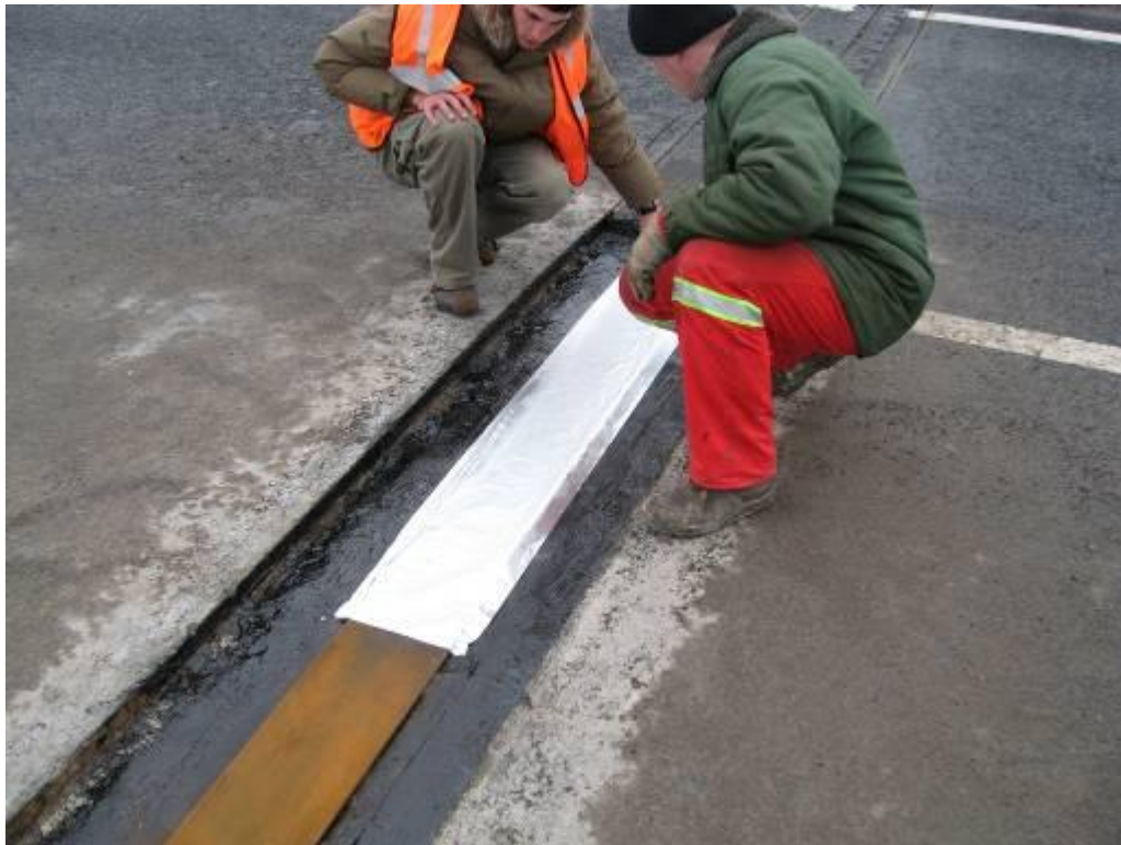
Рис14. Установка опорных пластин и укладка алюминиевой фольги.
