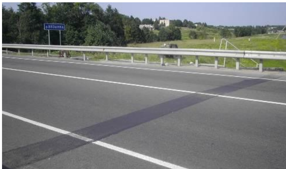
Рис.1. Общий вид щебеночно-мастичного деформационного шва.
