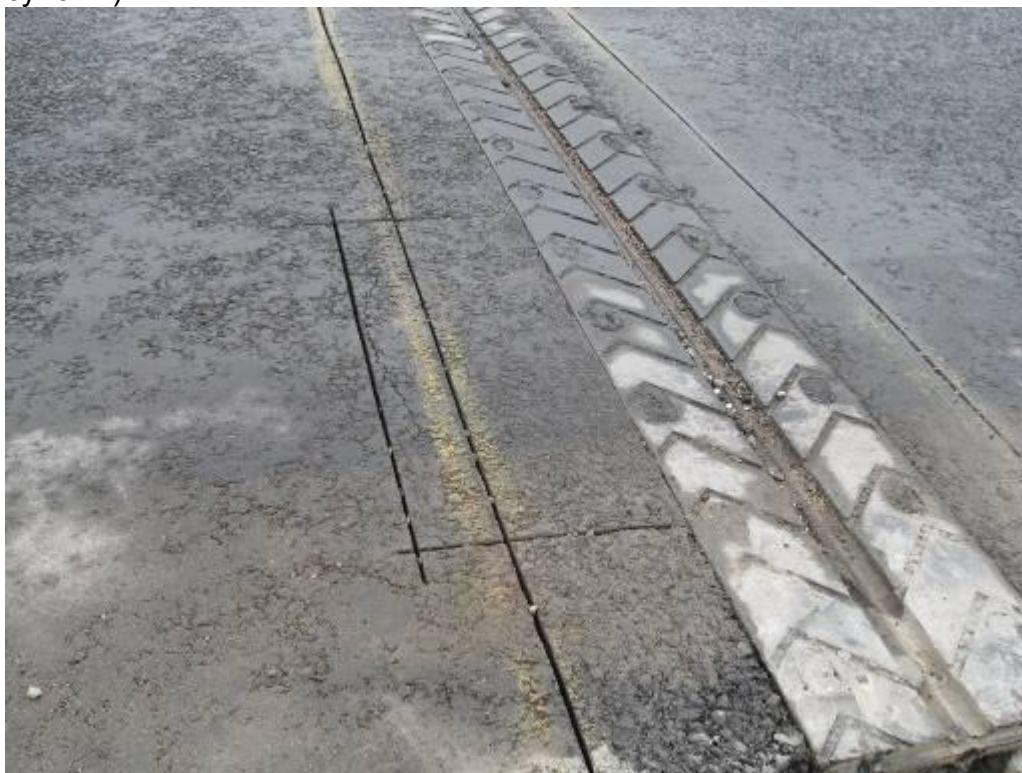
Рис.7. Оконтуривание шва с учетом локальных дефектов покрытия.
