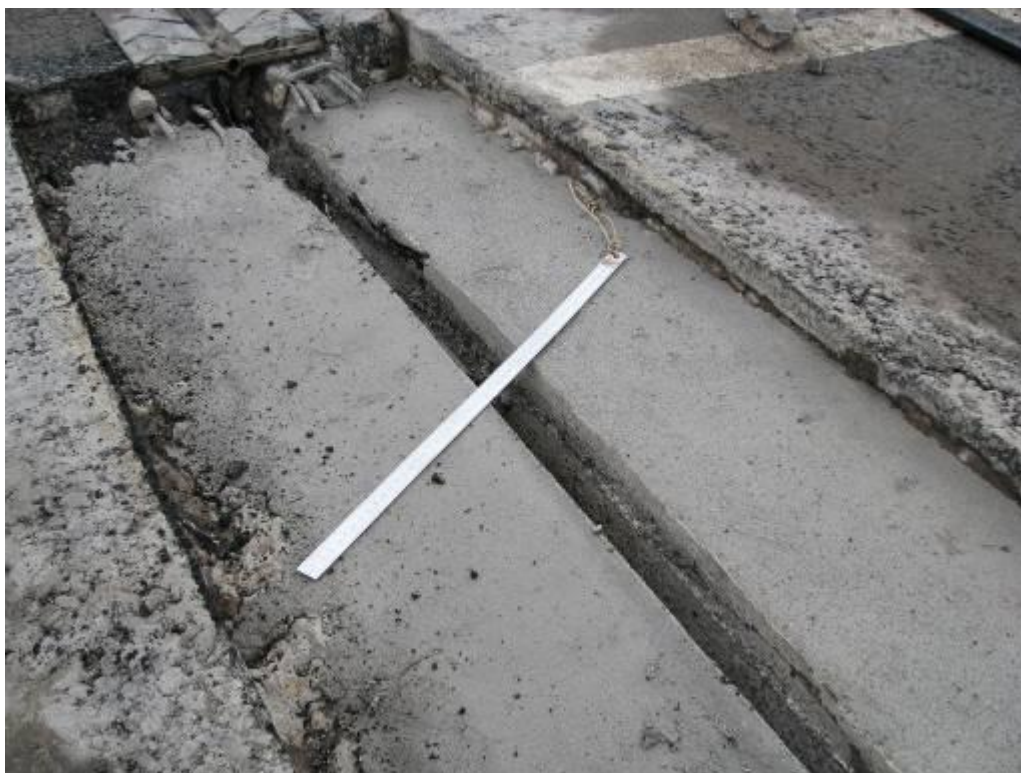
Рис.10. Выравнивание профиля шва
