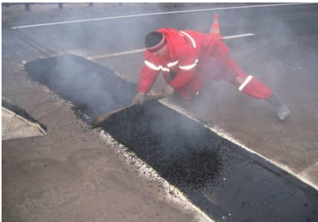
Рис.20. Распределение щебня фр.3-5мм.
